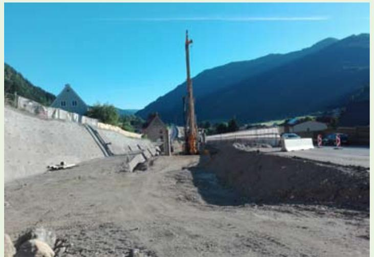
Der Block 46 im Bereich Kreuzung West wurde bereits im Juni fertig gestellt. In diesem Bereich wurden folgende Leitungen neu über dem fertig gestellten Deckel verlegt und sind bereits im Betrieb: Hauptwasserleitung, Schmutzwasserkanal Oberer Markt, Strom und SAT. Zusätzlich wurden einige Leerverrohrungen über die zukünftige Unterflurtrasse und unterhalb der zukünftigen Landesstraße verlegt.
