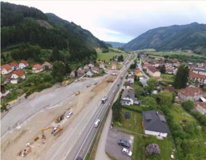
Anschließend erfolgte der Voraushub auf das zukünftige Niveau für die Errichtung der Deckel der Unterflurtrasse.
