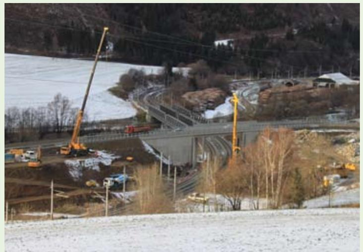
Ein größeres Projekt ist die Errichtung der neuen Schnellstraßenbrücke über die Südbahnstrecke der ÖBB. Nach Abbruch der Brücke im Oktober / November dieses Jahres werden derzeit die Bohrpfähle für die Fundamente gebohrt. Bis Weihnachten sollte die Fundierung beidseitig der Geleise fertig sein. Bis Ende März 2018 sollten die Widerlager der zukünftigen Brücke beidseitig errichtet sein.
