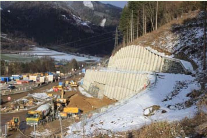
Die Stützmauer 12 mit einer Länge von 216 m wurde plan-mäßig Ende August fertig gestellt. Diese Ankerwand ist eine Hangsicherung für die zukünftige Landesstraße.
