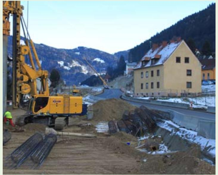
Bis jetzt sind von 1.800 Bohrpfählen für die zukünftige Unterflurtrasse bereits 1.200 fertig gebohrt und mit Beton gefüllt. Bis Ende März 2018 werden alle Bohrpfähle fertig sein. Die dazugehörigen Deckel werden bis Ende Juni 2018 fertig sein. Anfang Juli 2018 wird mit dem Durchgraben unter den fertigen Deckeln begonnen werden.
