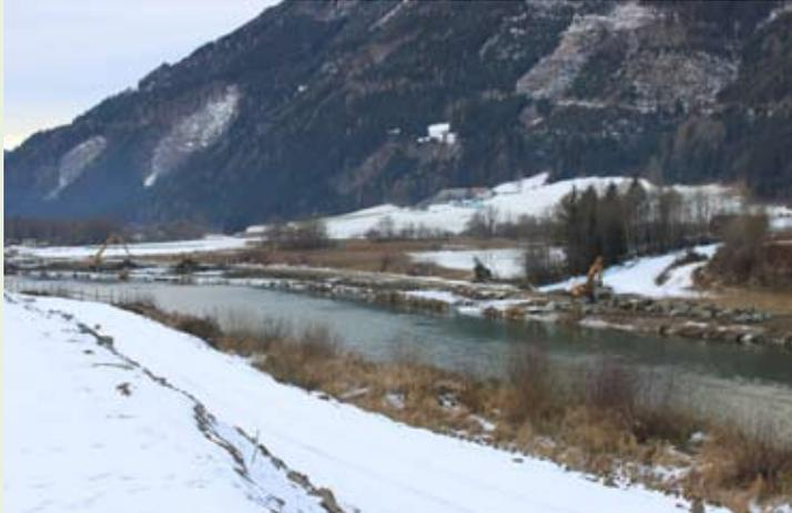
Mit der Murverlegung wurde linksufrig im Herbst begonnen und sollte bis Anfang April 2018 linksufrig fertig sein und damit auch die Behelfsbrücke nicht mehr benötigt werden. Hier werden ca. 100.000 m<sup>3</sup> Aushubmaterial ausgebaggert und auf die Deponie in Hirschfeld transportiert.
