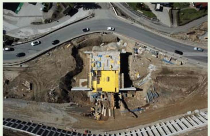
Die Schnellstraßenbrücke M57 ist bis Ende April fertig, anschließend wird nach der Straßenumlegung mit den Winkelstützmauern Richtung Scheifling und Richtung Judenburg (jeweils ca. 70 m Länge) begonnen. Im Juni wird die Verkehrsführung unter die Schnellstraßenbrücke verlegt werden. Bei den südlich der Schnellstraßenbrücke gelegenen Stützmauern SM 11 und SM 12 werden jetzt die Abdeckplatten angebracht und sind somit fertig.
