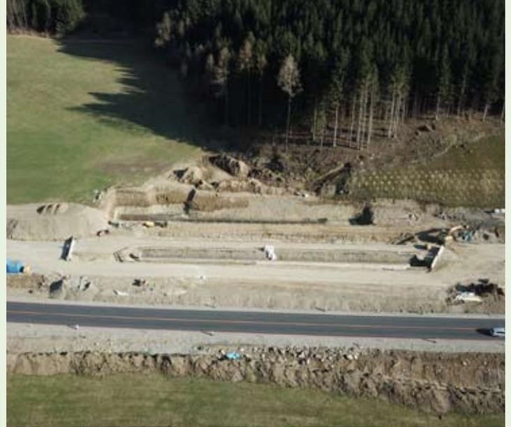
Die Wildüberführung besteht aus einem Tunnel mit drei Röhren, zwei Röhren für die Richtungsfahrbahnen der Schnellstraße Richtung Scheifling und Judenburg sowie eine Röhre für die zukünftige Landesstraße. Das gesamte Bauwerk wird zum Schluss eingeschüttet und begrünt. Anfang März wurden 123 Bohrpfähle gebohrt und betoniert. Anschließend die Fundamente darauf gebaut. Bis Ende Mai sollten die Wände der Wildüberführung fertig sein. Auf den Wänden wird bis Ende Juli das Tragwerk errichtet.
