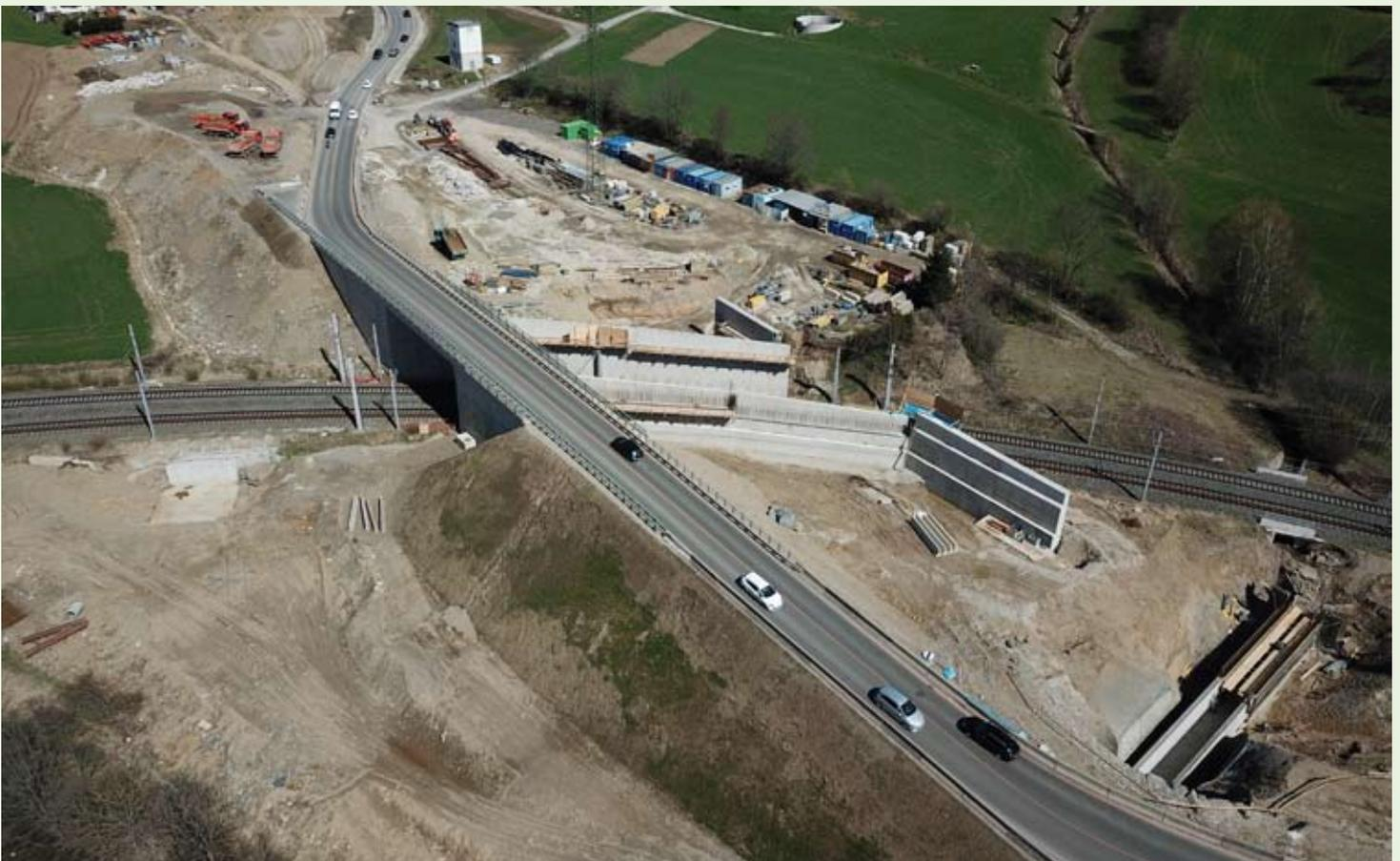
Hier musste zuerst die alte zweispurige Straßenbrücke abgetragen werden, um anschließend mit der Errichtung der neuen S36 Straßenbrücke beginnen zu können. Ende Mai werden die Fertigteilträger eingehoben. Im Juni wird der Betonbau mit den Randbalken und dem Aufbeton abgeschlossen werden. Anfang August wird die Brücke fertig gestellt. Das Gerinne des Ebringbaches wird Ende April fertig errichtet sein und anschließend zugeschüttet.
