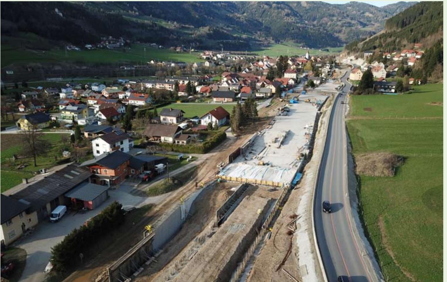
Die Bohrpfähle von Block 69 bis 76 sind fertig gebohrt, jetzt werden die Deckel betoniert. Derzeit wird ein Block pro Woche fertig. Anfang Juni sollten alle Blöcke Richtung Westen fertig sein. Anschließend wird mit dem Portalbereich begonnen.
