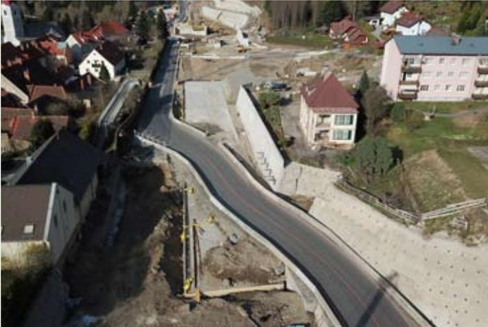
Nördlich vom Wohnhaus Kammerlander wurde die Südröhre (Blöcke 8 bis 15) im Herbst fertig gestellt. Nach erfolgter Verkehrsumleitung auf die fertige Südröhre ab Mai werden die 71 Bohrpfähle für die Nordröhre (Blöcke 8 bis 15) im Bereich Festsaal gebohrt. Weiters werden ab Mai 167 Bohrpfähle für die Blöcke 1 bis 7 (beide Fahrrichtungen) gebohrt. Zusätzlich wird der Abbruch des noch verbliebenen Restes des ehemaligen Fußgängerüberganges erfolgen.
