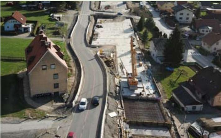
Die Südröhre für die Unterflurtrasse (Block 28 bis 40) im Bereich Oberen Markt wurde ebenfalls bereits letztes Jahr fertig gestellt und im Jänner der Verkehr darauf umgeleitet. Jetzt werden die Deckel für die Nordröhre betoniert. Die Baufirma arbeitet von Block 40 in Richtung Judenburg und ist jetzt bei Block 36 auf Höhe Gemeindehaus Oberer Markt.
