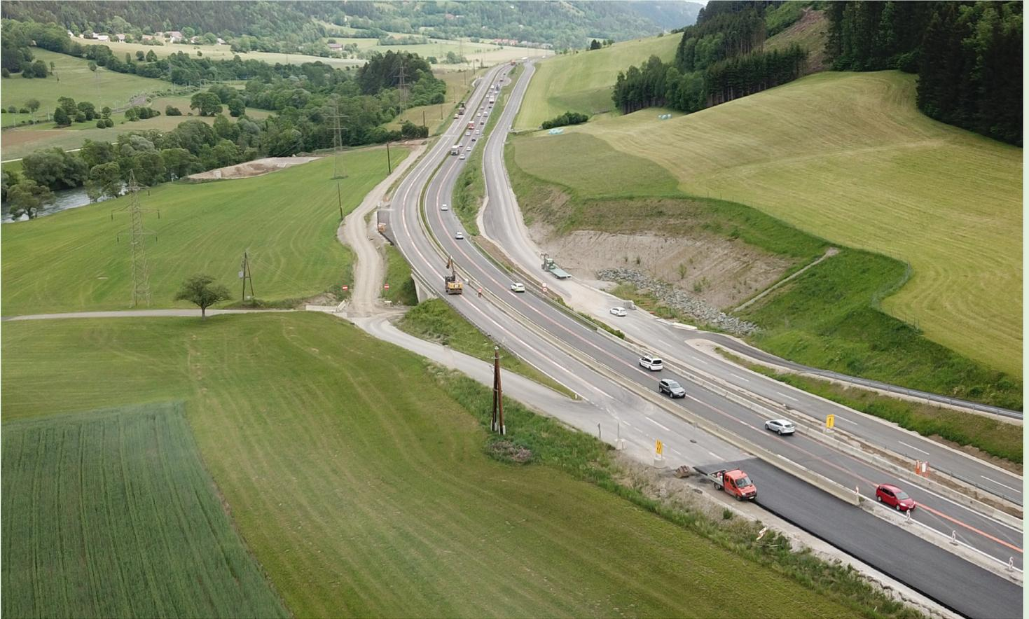
Die gesamte Freilandstrecke zwischen Unzmarkt-Frauenburg und St. Georgen ob Judenburg (Bestandesstrecke) wird saniert (abfräsen, stabilisieren, asphaltieren) und mit Pannenbuchten und neuen Leiteinrichtungen ergänzt. Die Arbeiten werden bis Ende Oktober abgeschlossen sein. Mit der Sanierung der Richtungsfahrbahn nach Scheifling wurde mittlerweile begonnen.
