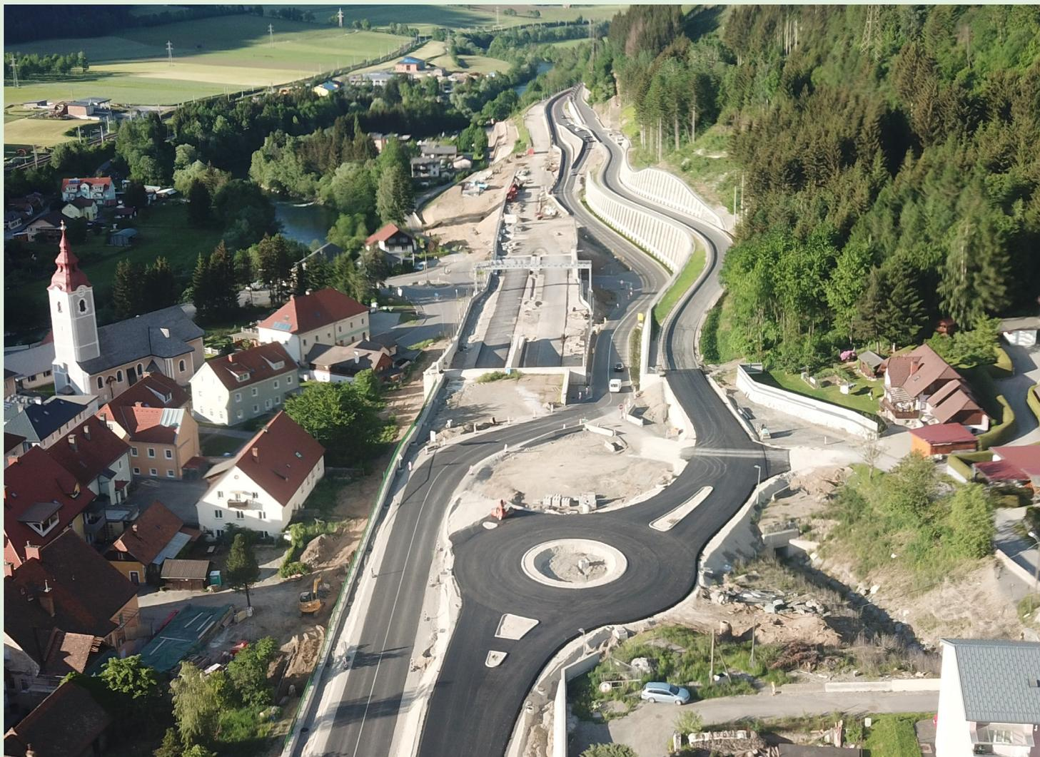
Der Kreisverkehr Mitte wurde Anfang Juni fertig errichtet und asphaltiert. Die provisorische Straße neben dem Festsaal wird wieder rückgebaut und die geplante Oberflächengestaltung umgesetzt.
