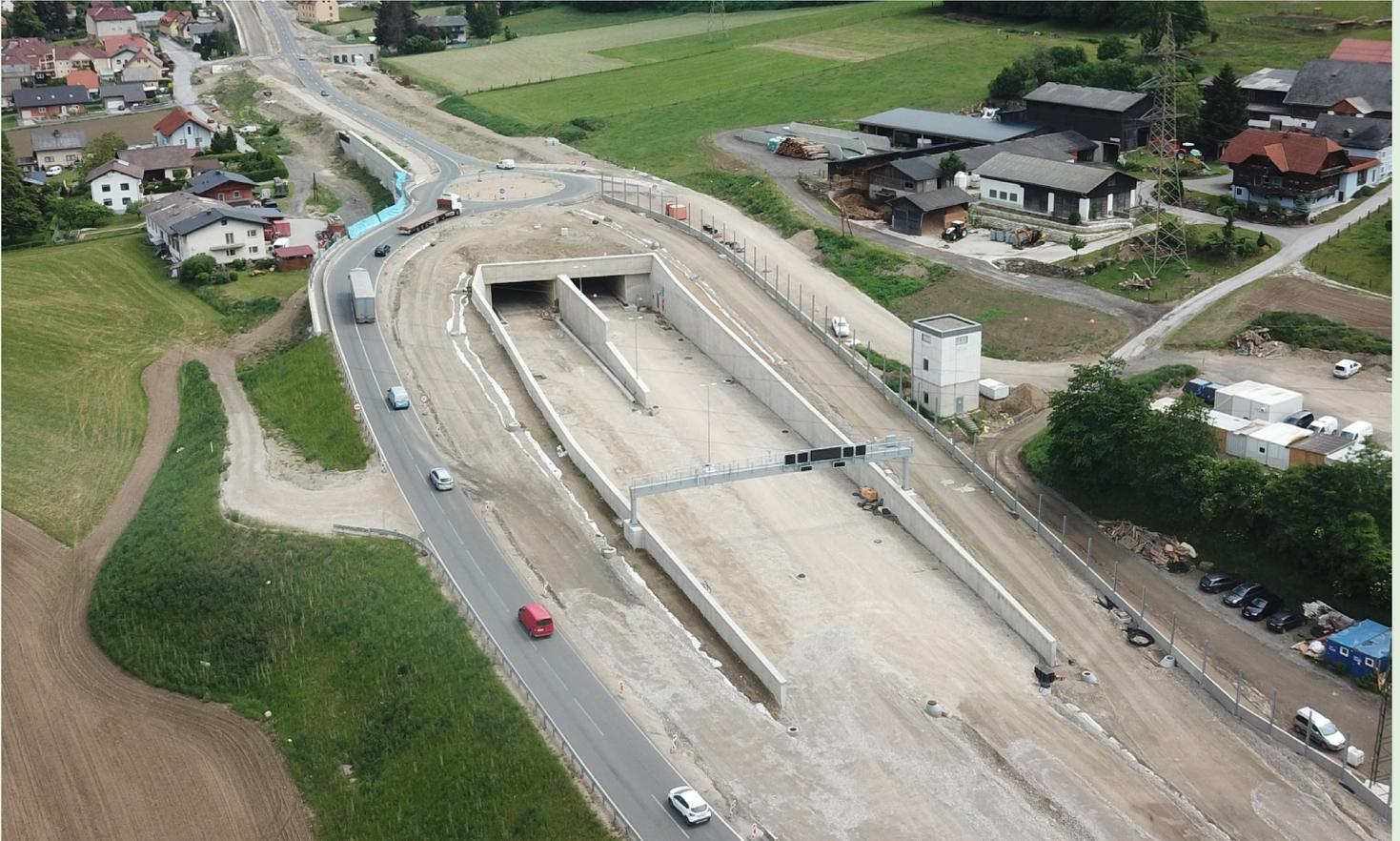
In der Unterflurtrasse werden nun die Kabelschächte mit eigenen Betonelementen sog. Kabelträgern verschlossen und die Kanaldeckel mit Gussasphalt abgedeckt. Bis Ende Juli wird dann noch eine Verschleißschicht aufgebracht. Die Elektrifizierung des Tunnels sowie die Anbindung der Pannensäulen auf der Freilandstrecke werden bis Ende Oktober abgeschlossen sein.
