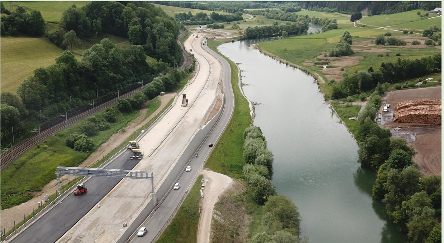
Richtung Westen wird bis Ende August die Asphaltierung bis Ausbauende abgeschlossen sein. Die 6 Absetzbecken werden mit einer Folie ausgelegt und anschließend eine Schicht Schutzbeton aufgebracht. Dann wird der organische Filter bestehend aus einem Gemisch aus Sand und Humus, eingebracht. Zusätzlich gibt es zwei Gewässerschutzbecken mit einem technischen Filter bei der Abfahrt Unzmarkt Ost und rechtsufrig von der Mur vor der Murbrücke in Unzmarkt.
