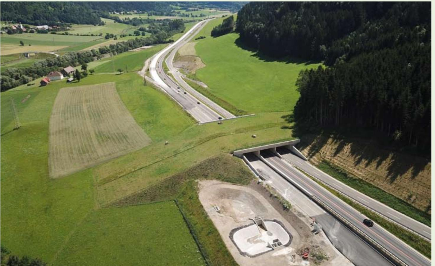
Der Wildübergang im Osten ist gut angewachsen und wird vom Wild hoffentlich entsprechend angenommen. Im Vordergrund eine inzwischen fertig gestellte Gewässerschutzanlage. Die bestehende Straße zwischen St. Georgen und Unzmarkt wurde in beiden Fahrrichtungen saniert und eine neue Asphaltdecke aufgebracht.
