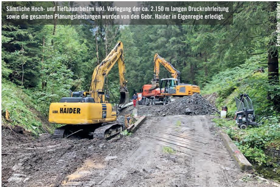
Sämtliche Hoch- und Tiefbauarbeiten inkl. Verlegung der ca. 2.150 m langen Druckrohrleitung sowie die gesamten Planungsleistungen wurden von den Gebr. Haider in Eigenregie erledigt.
