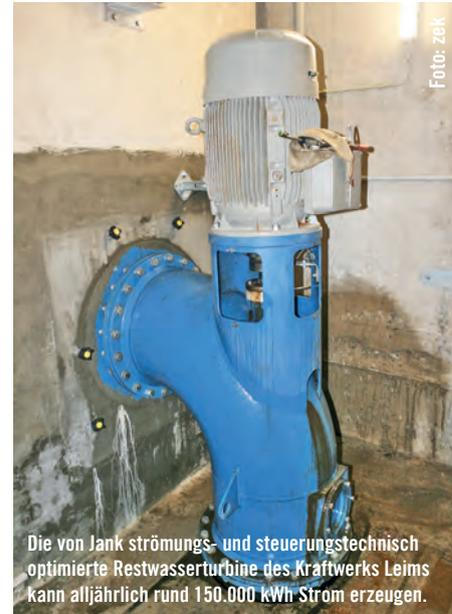
Die von Jank strömungs- und steuerungstechnisch optimierte Restwasserturbine des Kraftwerks Leims kann alljährlich rund 150.000 kWh Strom erzeugen.
